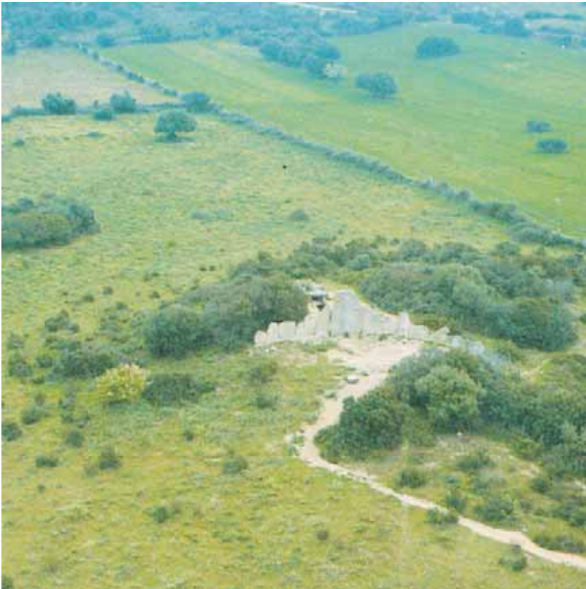
Fig.36 Tomba di giganti di Li Lolghi: veduta aerea.
