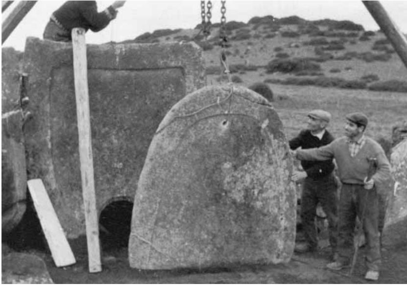
Fig. 43 Tomba di giganti di Coddu Vecchii: fase di restauro della stele centinata.
